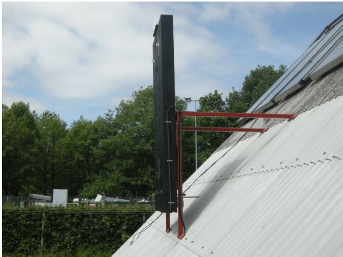
Figur 1. Principskitse (til venstre) og foto (til højre) af luftsolfangersystemet.
