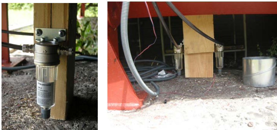
Figur 11. Kondensfælde/kondensopsamler
